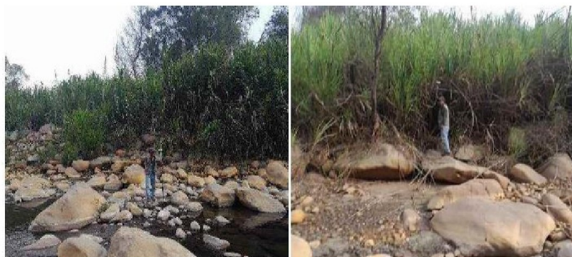
IMAGEN CAUCE DE RIO MOCHE TRAMO A DESCOLMATAR
