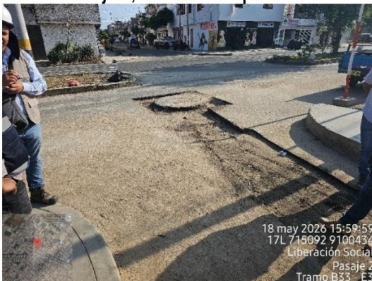
Vista fotográfica n.º 13 Tramo entre los buzones B33 al E3 del Pasaje 2, a nivel de imprimante
