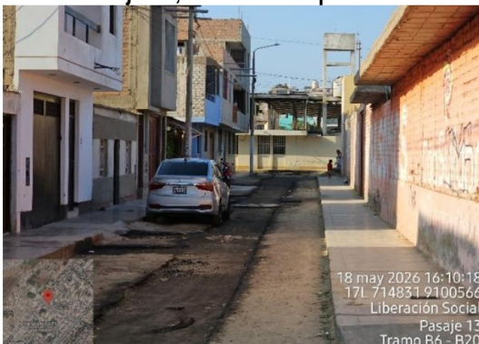
Vista fotográfica n.º 15 Tramo entre los buzones B6 al B20 del Pasaje 13, a nivel de imprimante
