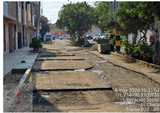
Tramo entre los buzones B28 al B9 de la avenida Chota, a nivel de imprimante
