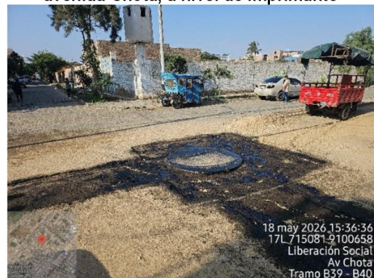
Tramo entre los buzones B28 al B9 de la avenida Chota, a nivel de imprimante
