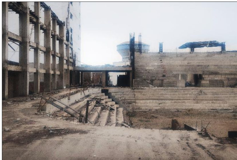
Imagen n.º 2 Vista general de coliseo cerrado
