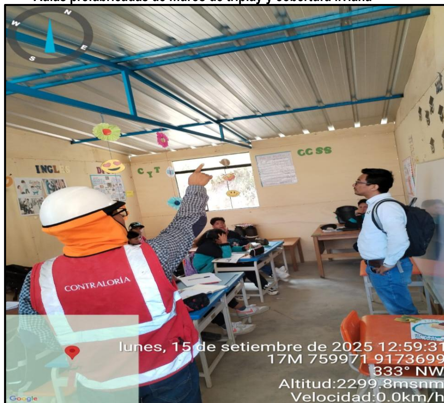
Imagen n.º 28 Aulas prefabricadas de muros de triplay y cobertura liviana
