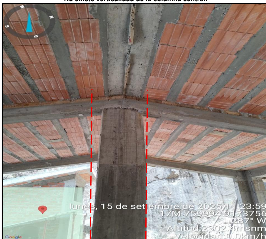
Imagen n.º 9 No existe verticalidad de la columna central.
