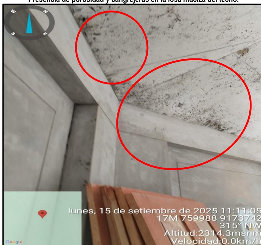
Imagen n.º 6 Presencia de porosidad y cangrejas en la losa maciza del techo.
