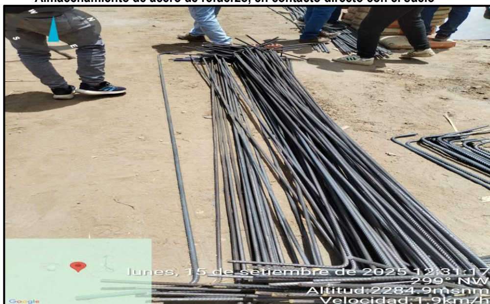
Imagen n.º 26 Almacenamiento de acero de refuerzo, en contacto directo con el suelo
