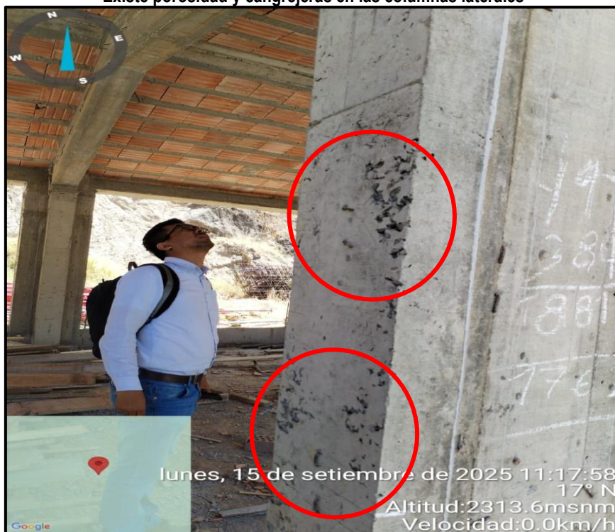
Imagen n.º 10 Existe porosidad y cangrejas en las columnas laterales
