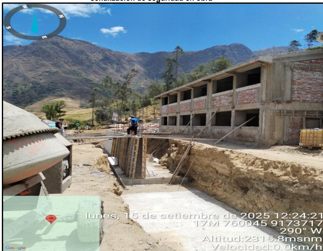
Imagen n.º 25 Trabajos incompletos en las partidas de concreto armado del muro de contención, sin señalización de seguridad en obra
